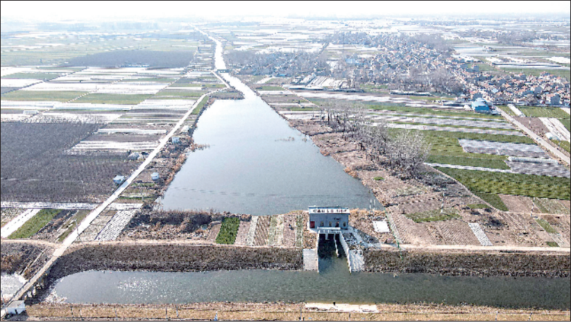
位于沛敬公路西侧的鹿口南支河闸站 2020 年 4 月建成投入使用后，大大增强了鹿口南支河的排涝和灌溉功能。 徐报融媒记者 白雪 摄
